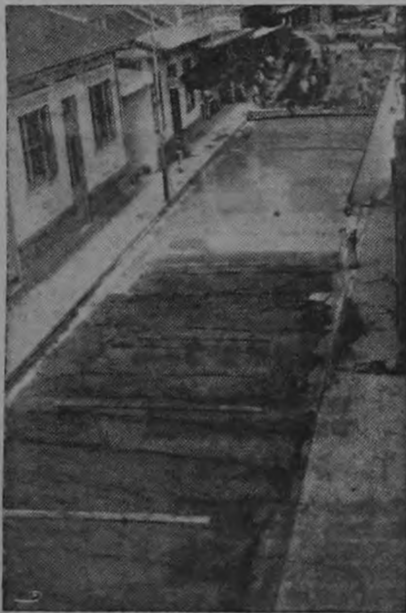
La mayoría de nuestras calles tienen de 20 a 30 años de intenso servicio. Más de 25 kilómetros de ellas deben ser construidas en su totalidad. Del presupuesto 1963 ₡ 264.146.95 han sido destinados a la construcción de calles nuevas, trabajo que ya se realizó
