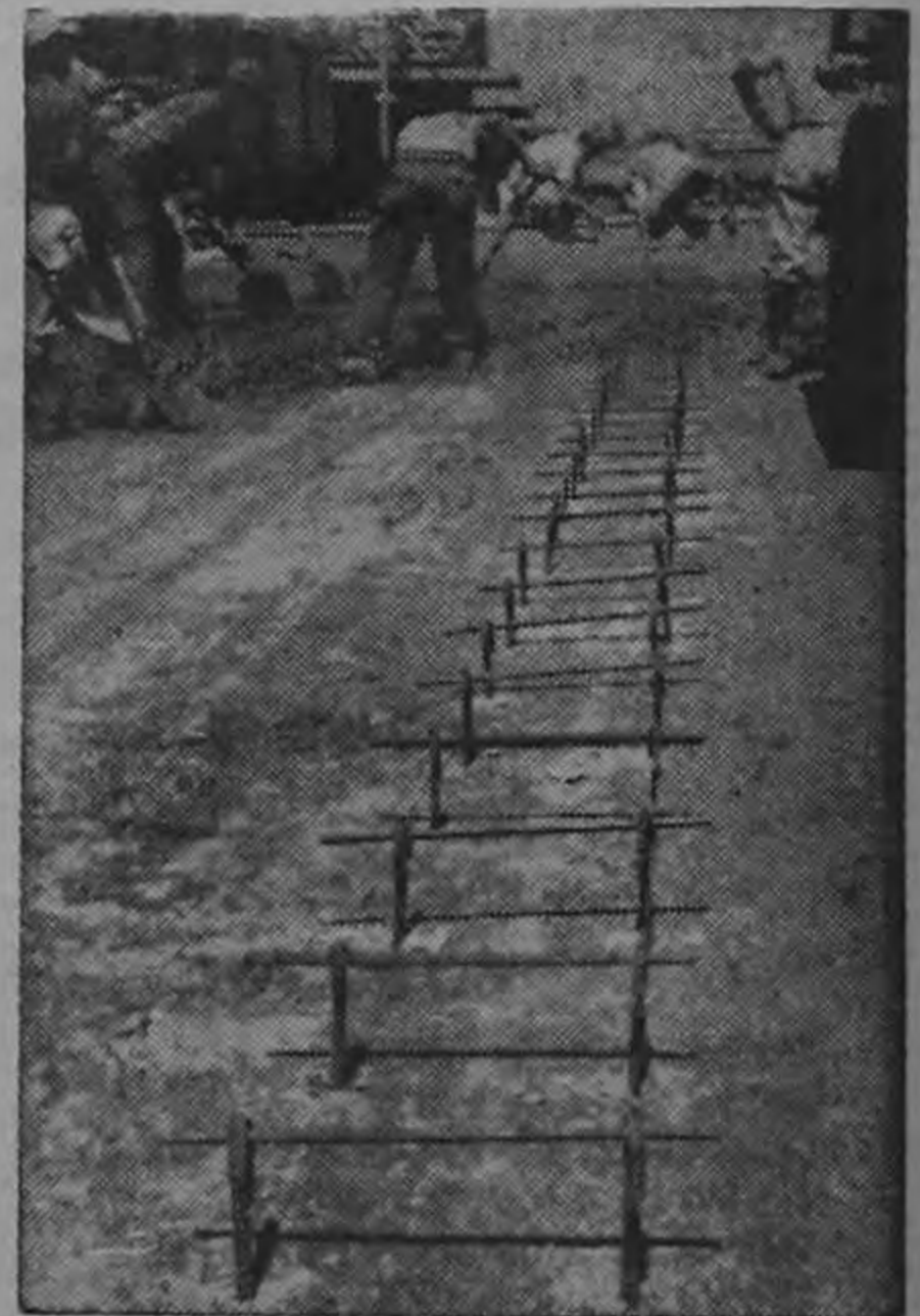
La duración de nuestras calles depende en gran parte de la base misma. El costo de una calle es alto, aproximadamente ₡ 47.000.00 una cuadra. La calidad de los materiales, acero, cemento, piedra, debe ser excelente. De esto depende su duración
