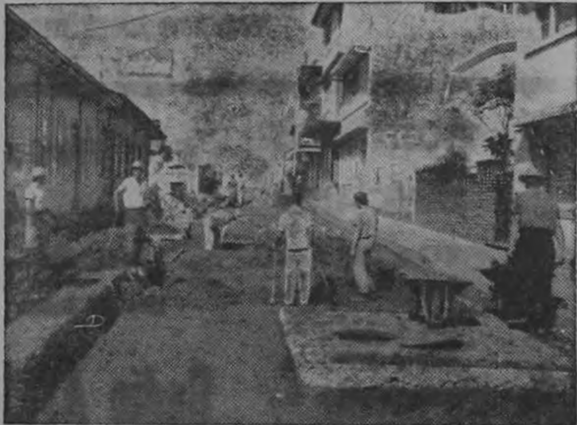
El promedio de metros cuadrados de bacheo es de enero a agosto de 2.741 m 2 . Con el nuevo sistema de trabajo iniciada en el lluvioso mes de setiembre, el rendimiento fue de 5.166 m 2 - 2.425 m 2 a favor del nuevo sistema
